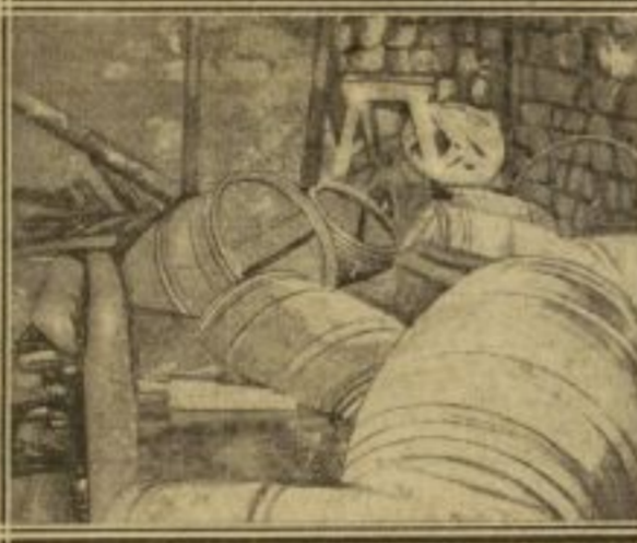
CAVE INONDÉE RUE VILLIOT, A PARIS
