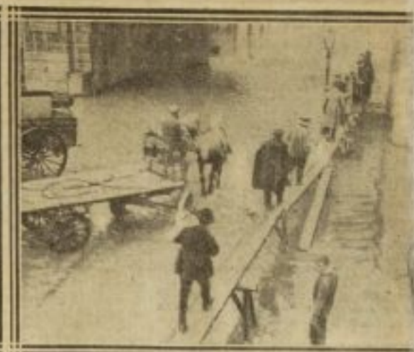
PASSERELLE ÉTABLIE QUAI DE LA GARE
