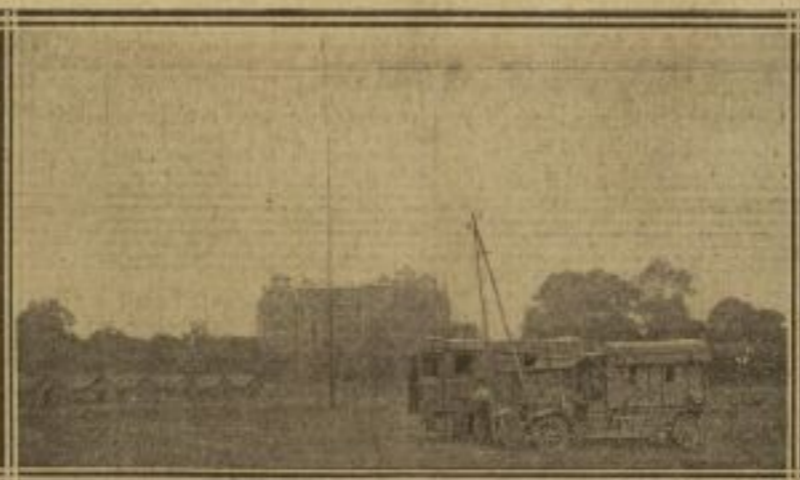
LE POSTE DE RADIO, DERRIÈRE LE GRAND-CONDÉ
